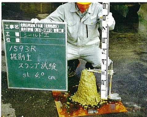
掘削土砂 (改良)
