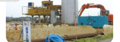
河川浚渫改良工事
