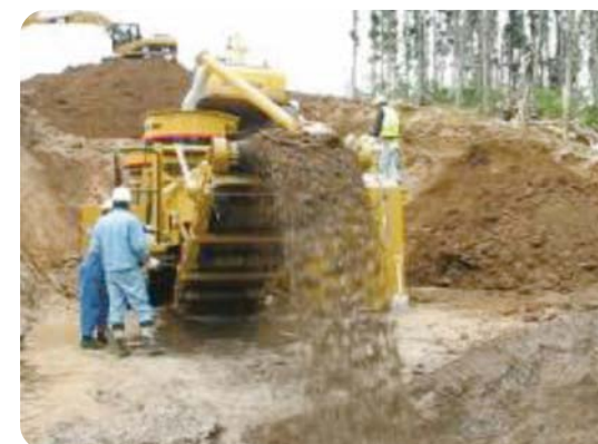
高速道路体改良工事
