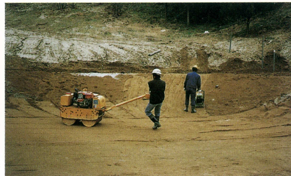
③タングレット・スメクタイト防水層の上に覆土を行い、30cmに転圧
