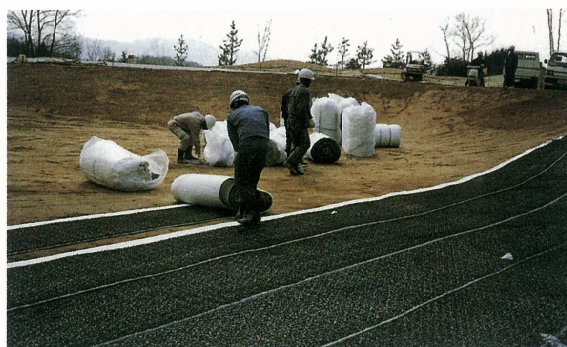
①防水基盤の整地・転圧後、タングレットを布設
