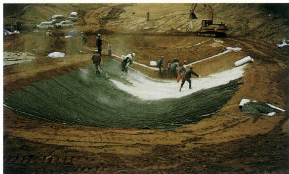
②スメクタイト防水材「バリア2500」をタングレットの上に散布・敷きならし
