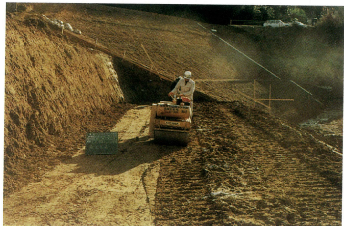
③転圧ローラーによる締め固め
