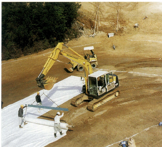
ベントフィックス布設
